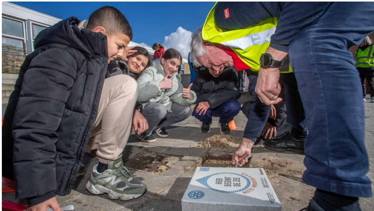
De eerste tegels werden geplaatst op het plein van de Kindercampus. Foto's: © Foto Miché / Bastiaan Miché
